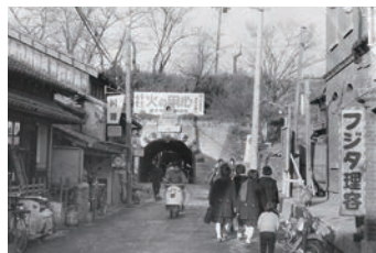
草津川マンボ(1963年、西岡写真工房提供)
