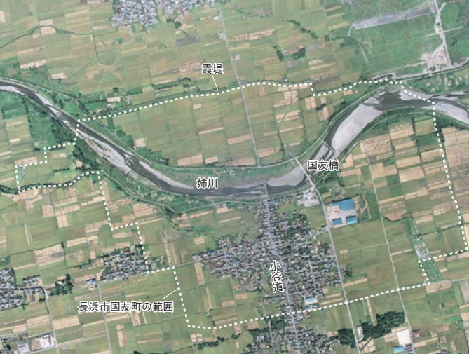
↑昭和50年（1975）撮影の空中写真（国土地理院サイトより）
